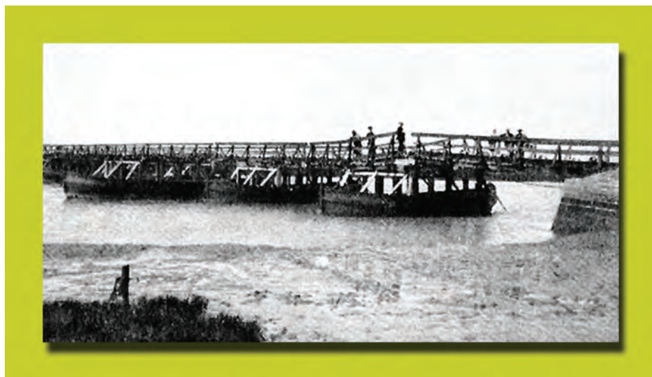
Figura 7. Puente de barcas sobre el caño Zurraque (Chiclana de la Frontera), comienzos del s. XX. Fotografía gentileza del Archivo Fotográfico de Diario de Cádiz. Como en época romana, con puente levadizo y cabeceras de piedra.
