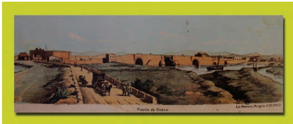
Figura 4.– El Sitio Histórico del puente Suazo en un grabado de la Litografía Alemana de la segunda mitad del siglo XIX. El entorno no debió de ser muy distinto al de época romana. Gentileza del Archivo Fotográfico de Diario de Cádiz.
