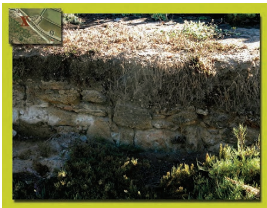
Figura 16. – Detalle de la estructura anterior, formada con bloques de piedra ostonera. El pavimento de la calzada lo cubre un estrato probablemente originado tras el tsunami de 1755. Arriba, su localización.
