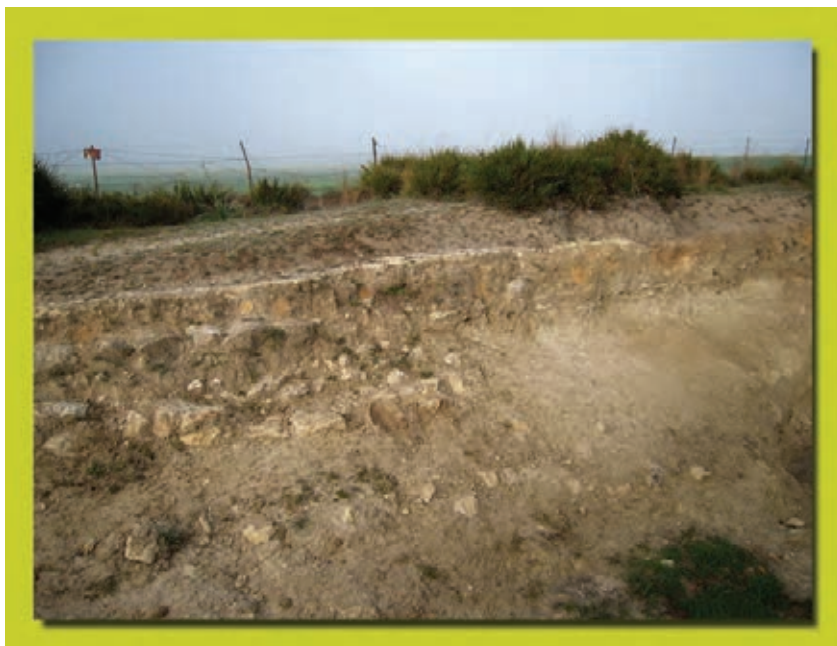
Figura 72. Estratigrafía resultante del desmoronamiento causado por la lluvia y el uso del Camino de los Romanos a la altura de la laguna Salada, apreciándose en el perfil su paramento exterior Este y el relleno de la estructura viaria. En la parte superior, en tonos blancos, se vislumbra el piso de rodamiento de la vía.
