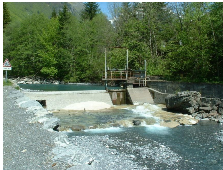
Photo 19 : Prise d'eau de microcentrale hydroélectrique sur le Giffre (source : SM3A)
