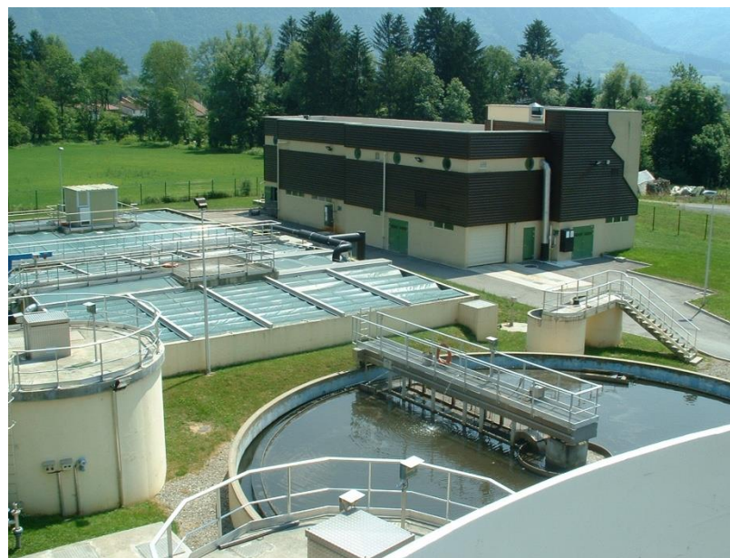
Photo 23 : Station d'épuration de Bonneville (source : SM3A)
