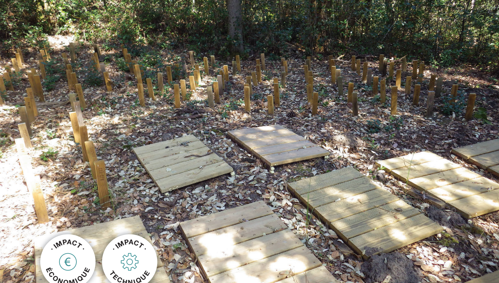
▲ Installation de platelages à l'île d'Oléron
