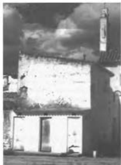
Foto 6). «La Torre de cal y ladrillo» de Sant Jaume de Fadrell.
