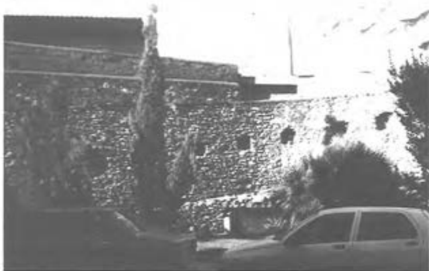
Foto 36). «Restos de la Batería del Gas o del Molino» (Castelló).
