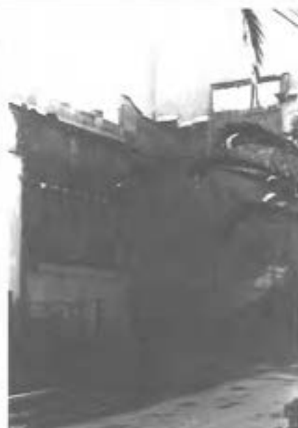
Foto 25). «Emplazamiento de la Torre Cap de la Vila».
