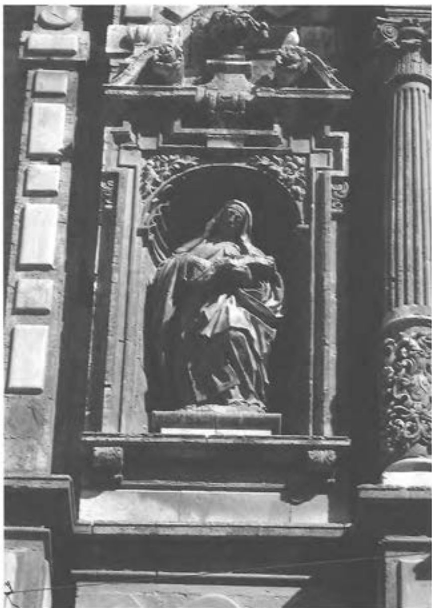
FIGURA 6: FACHADA DEL CONVENTO DEL CARMEN (VALENCIA)
