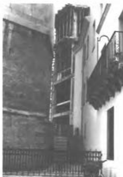
(Foto 21) «Lateral del actual Campanario de Castelló».
