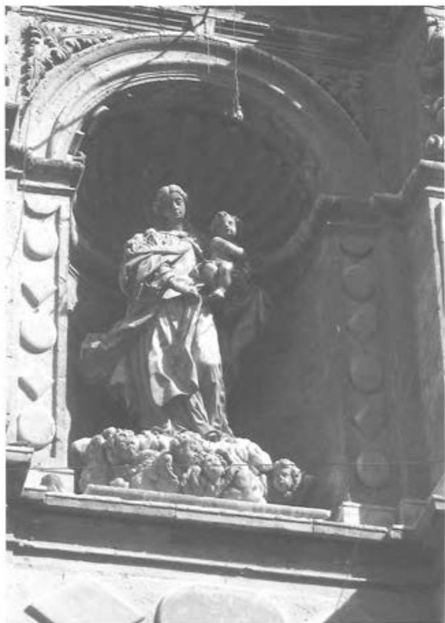
FIGURA 7: FACHADA DEL CONVENTO DEL CARMEN (VALENCIA)
