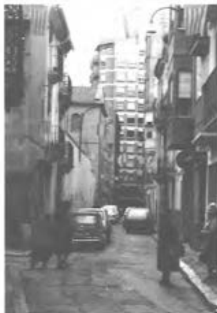
Foto 22). «Calle Pescadores», Primera calle de Castelló.
