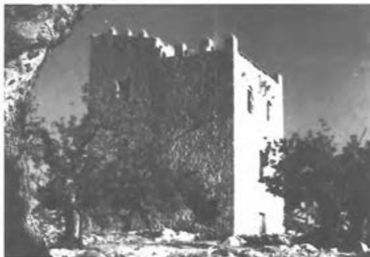
Foto 34). «La Torreta de Alonso» (Castelló).
