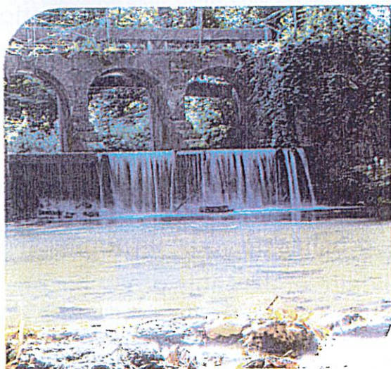
Les vannes sur l'Hogneau (chemin Lucq)
