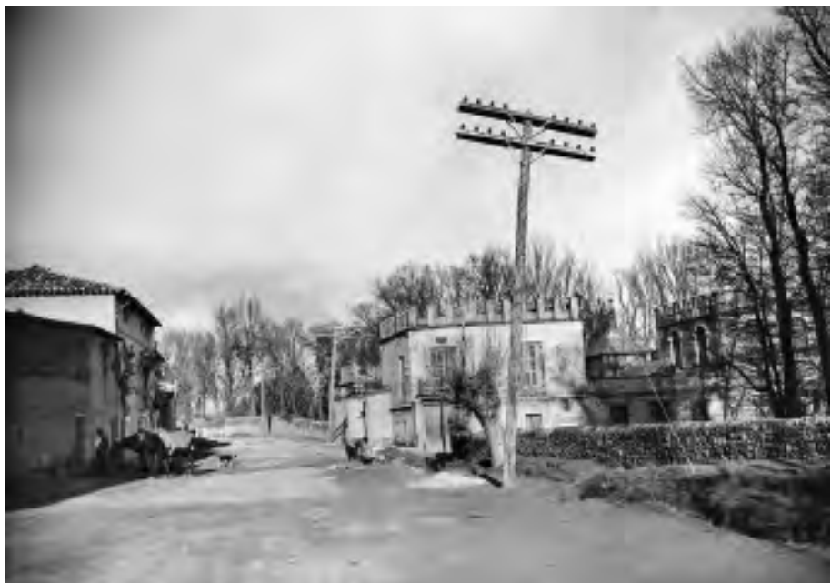
Carretera de Madrid a Francia por La Junquera. Travesía de Santa María de Huerta. Fundación Telefónica.
