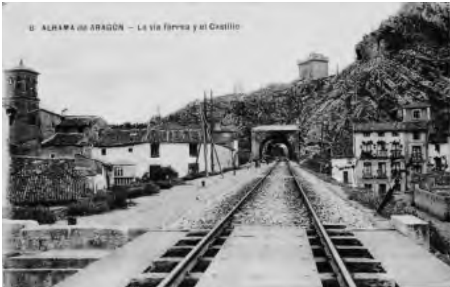
Alhama de Aragón. Vía férrea y túneles. Tarjeta postal.
