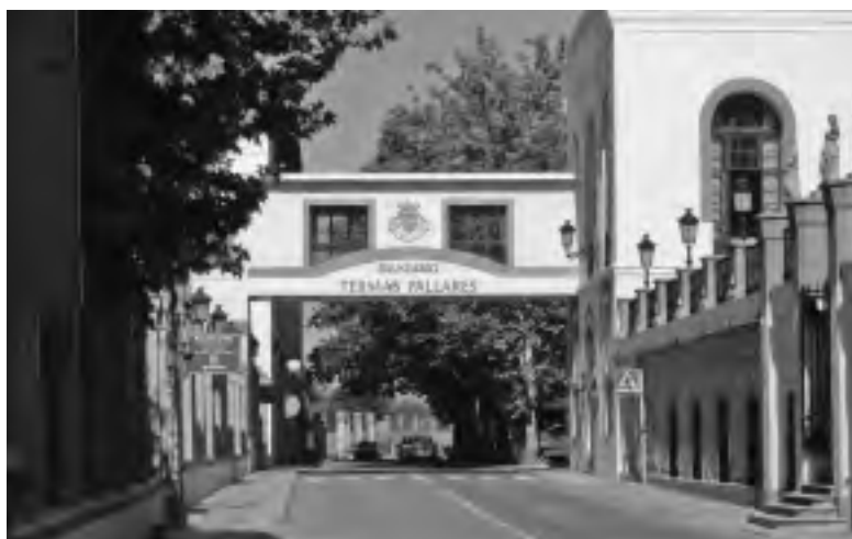
Alhama de Aragón. Balneario de Termas Pallarés. Pasarela sobre la N-II
