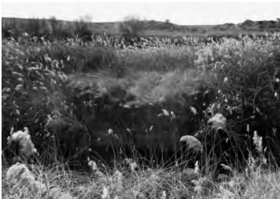
Matillas. Restos del puente sobre el Henares en Los Molinos de Edancho.
