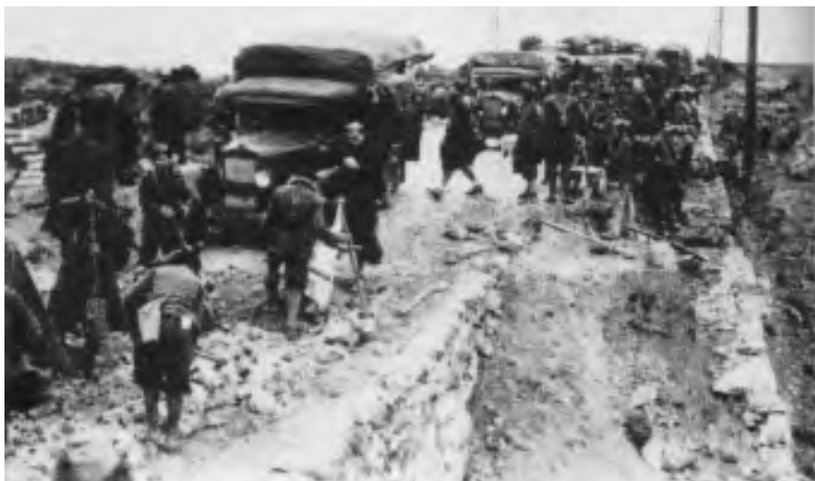
Almadrones. Puente del Obispo (antiguo km 105). Soldados trabajando junto al puente durante la batalla de Guadalajara (1937).
