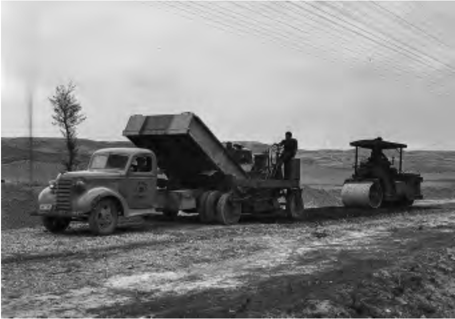
Carretera de Madrid a Francia por La Junquera. Obras en las cercanías de Ariza. Fototeca del Patrimonio Nacional, Archivo Pando.
