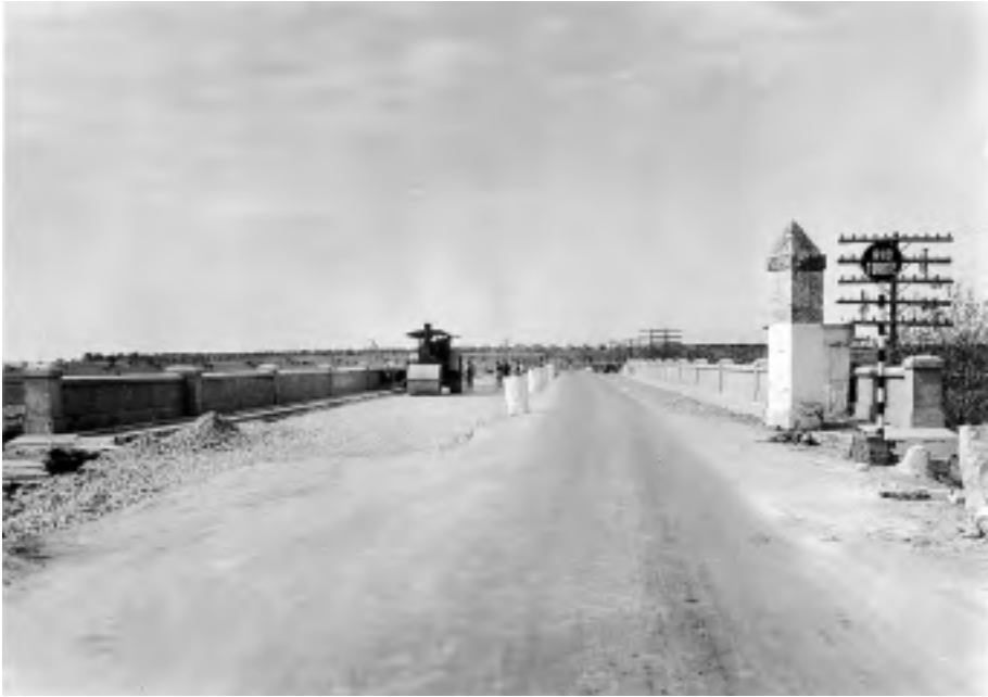
Ampliación de la calzada en el puente del río Torote. Fototeca del Patrimonio Nacional, Archivo Moreno.
