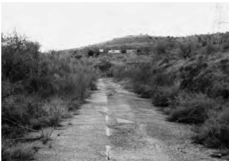
Morata de Jalón. Rampas del puerto de Morata, vertiente oriental, antigua carretera general.
