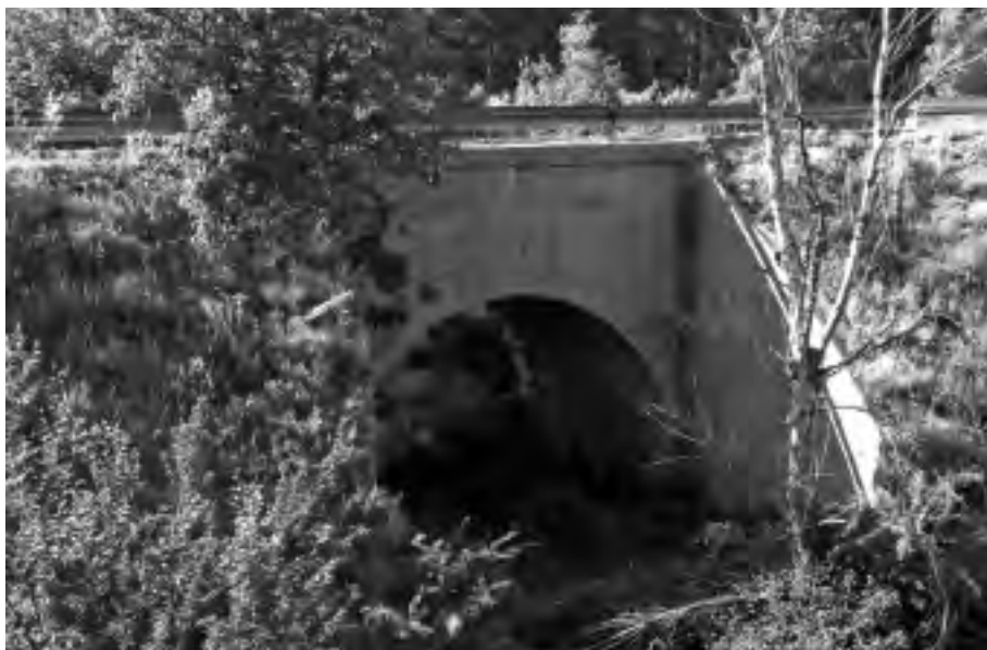
Bubierca. Puente del barranco de las Nogueras II.
