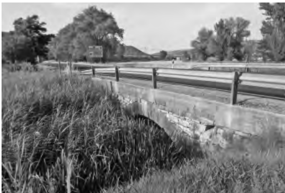
Fuencaliente de Medinaceli. Segundo puente sobre el Jalón.
