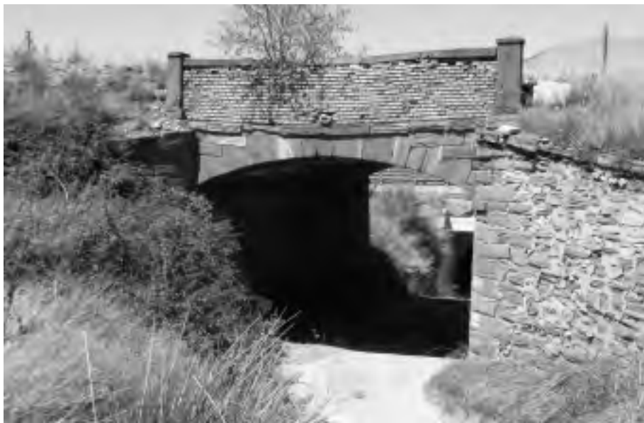
El Frasno. Puente del barranco del Maguillo.
