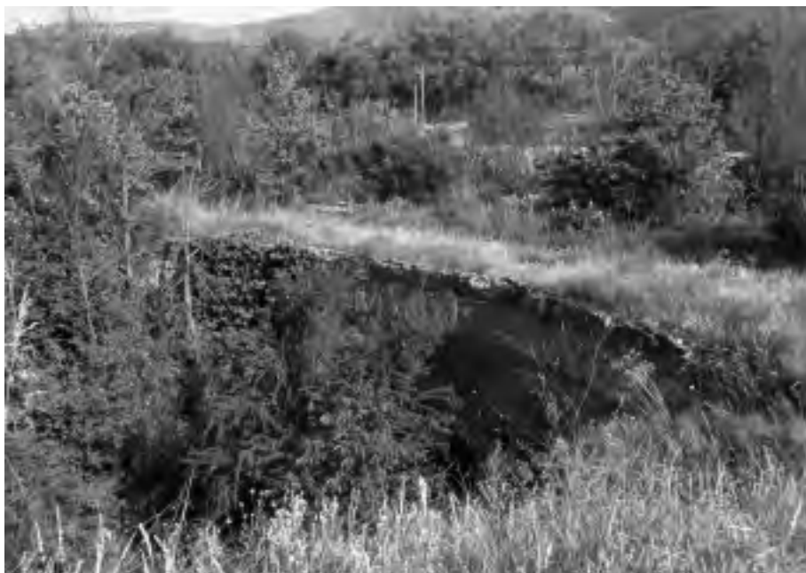
Bubierca. Puente del barranco de las Nogueras I.
